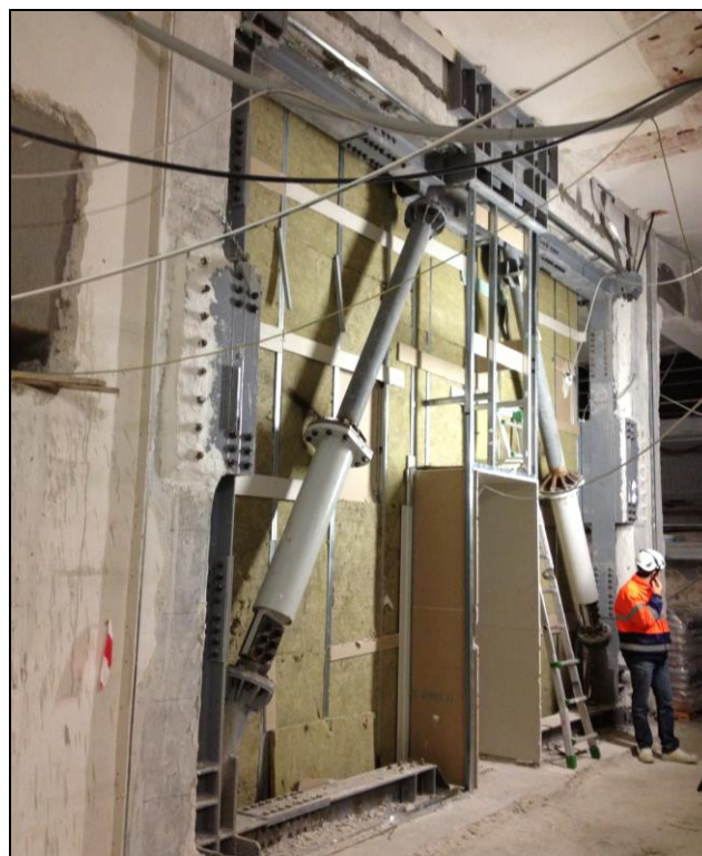
Figura 17 – Telaio con dissipatori
